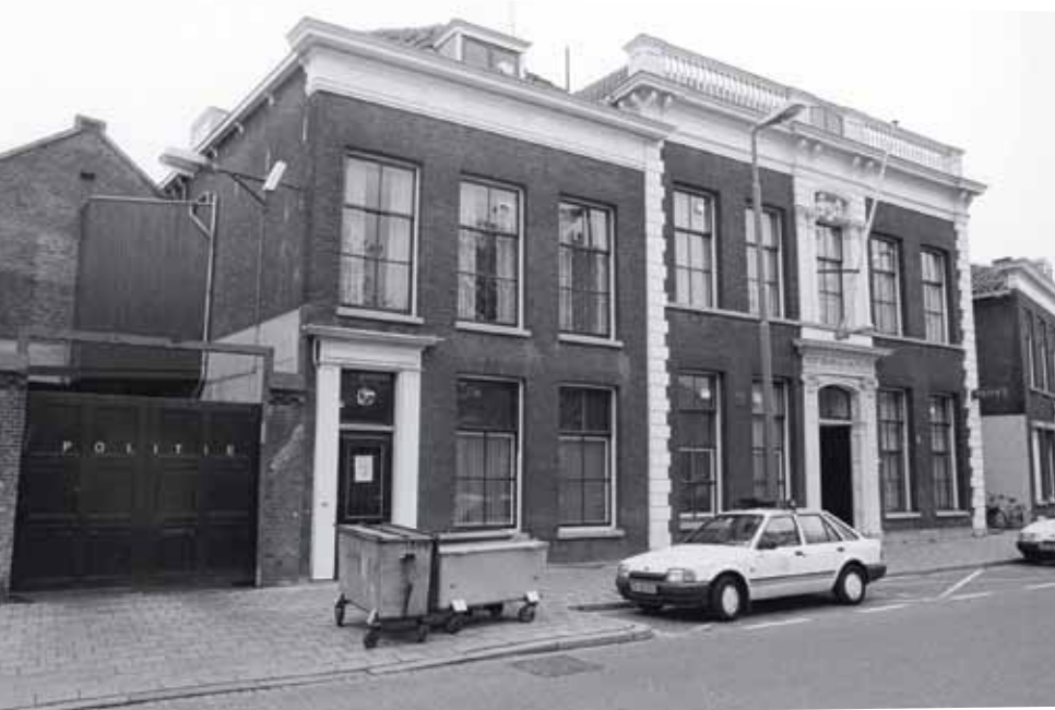
Politiebureau aan de Lange Nieuwstraat. Foto: Roel Dijkstra
