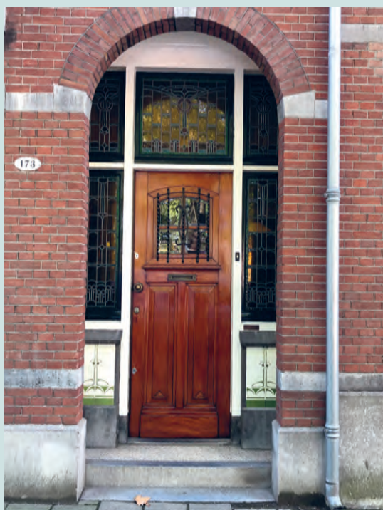
Voordeur van het huis met het glas in lood
