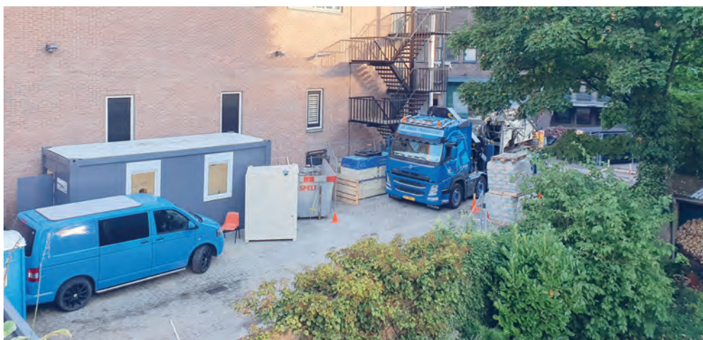
Groot materieel op de binnenplaats van het pand, september 2022, Foto: Anja Beverwijk
